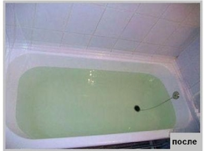
Реставрация ванны акриловым вкладышем AvizInfo.ru
