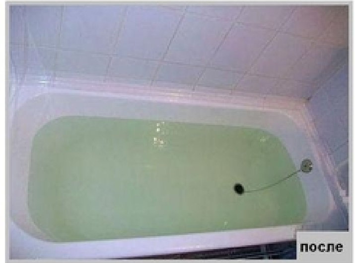
Реставрация ванны акриловым вкладышем AvizInfo.ru
